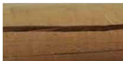
Fentes, gerces et fissures
